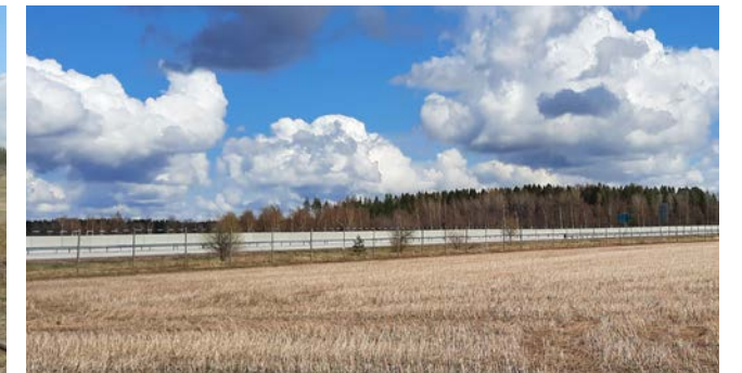
Moottoritien betoninen melueste.
