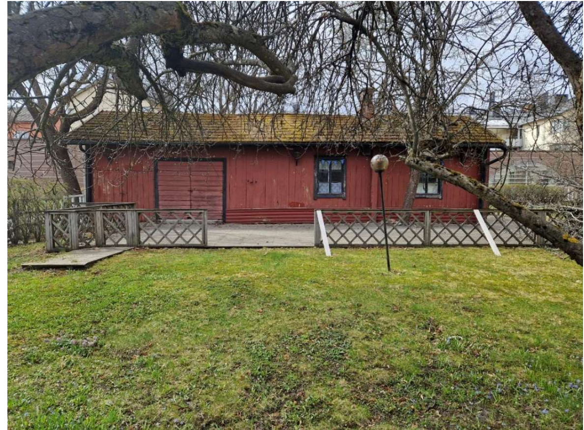
Kuva 54. Piharakennuksen julkisivu itään.
