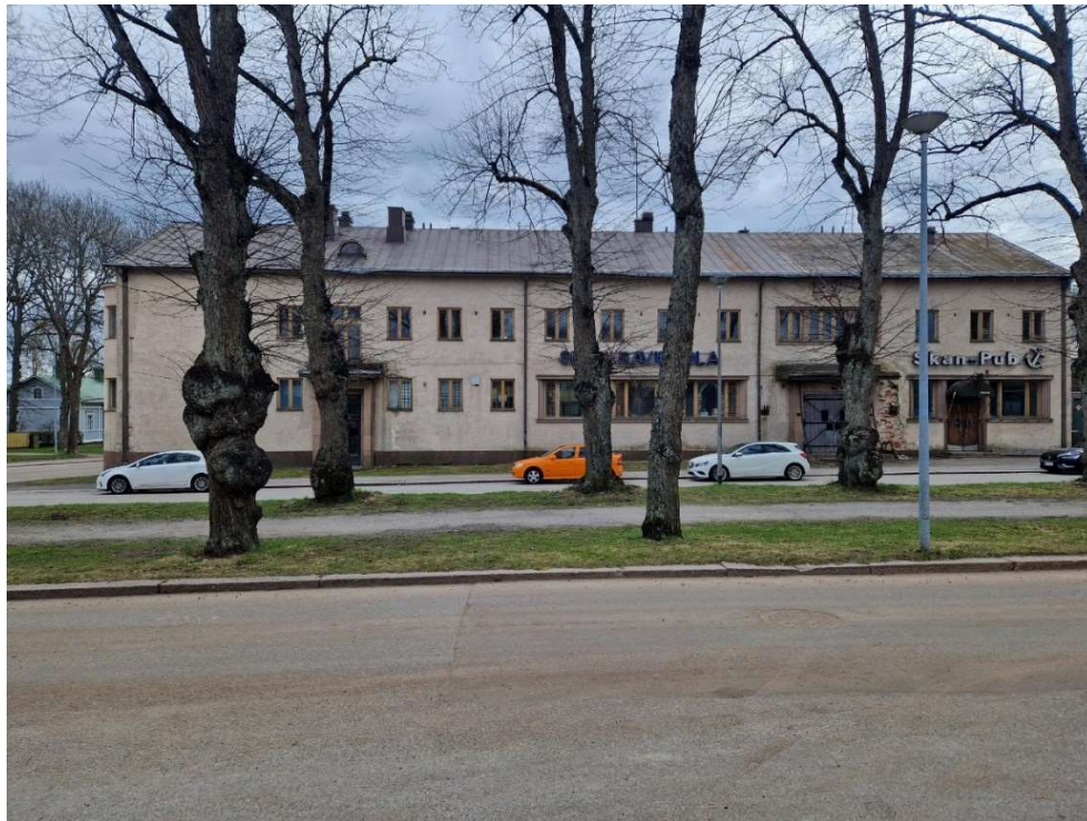
Kuva 21. Julkisivu pohjoiseen Karslkronabulevardille.
