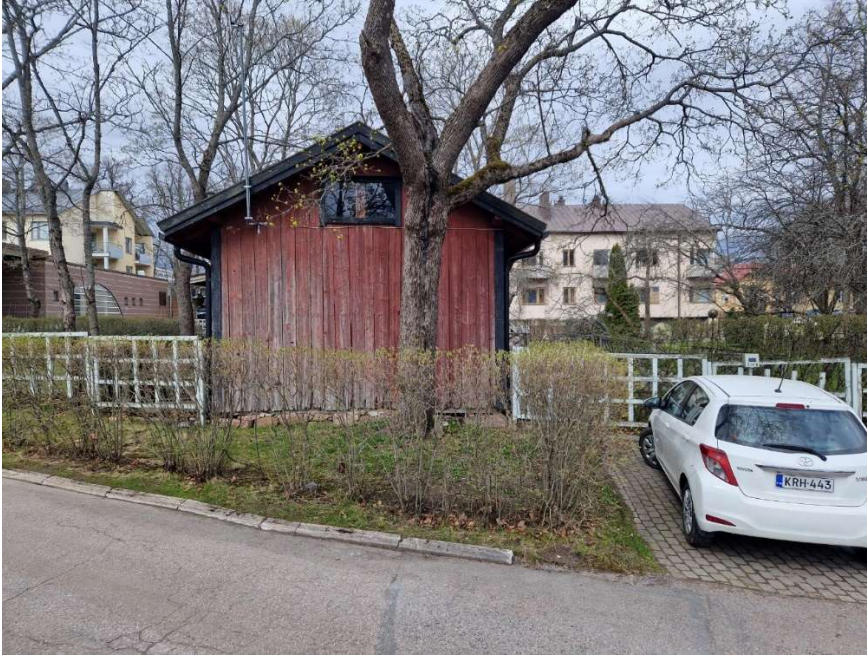
Kuva 51. Piharakennuksen julkisivu etelään.
