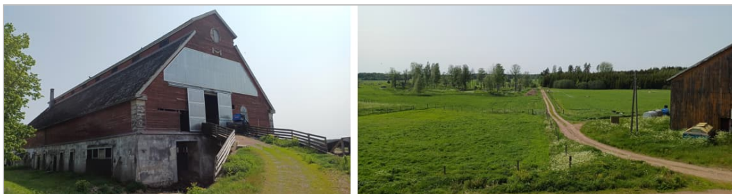
Bild 2. Ladugårdens fasader mot nordväst och utsikten över åkern från adugårdsbron. (Fotonr: Kaija Maunula, juni 2025)
