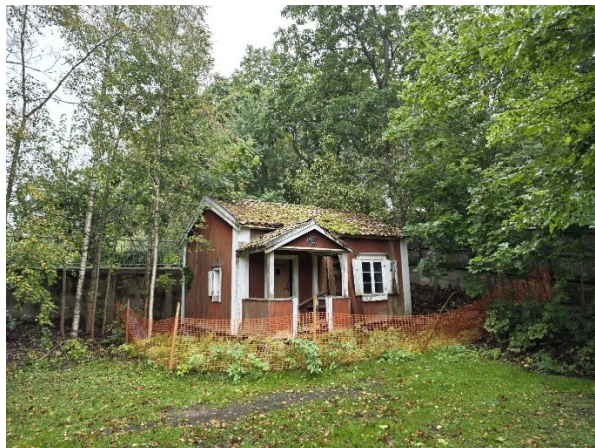
Kuva 2-3. Rakennus 3 (vanha asuinrakennus).
