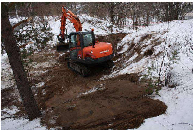
AKDG5145:23 Provdiket fylls igen. Från norr.
