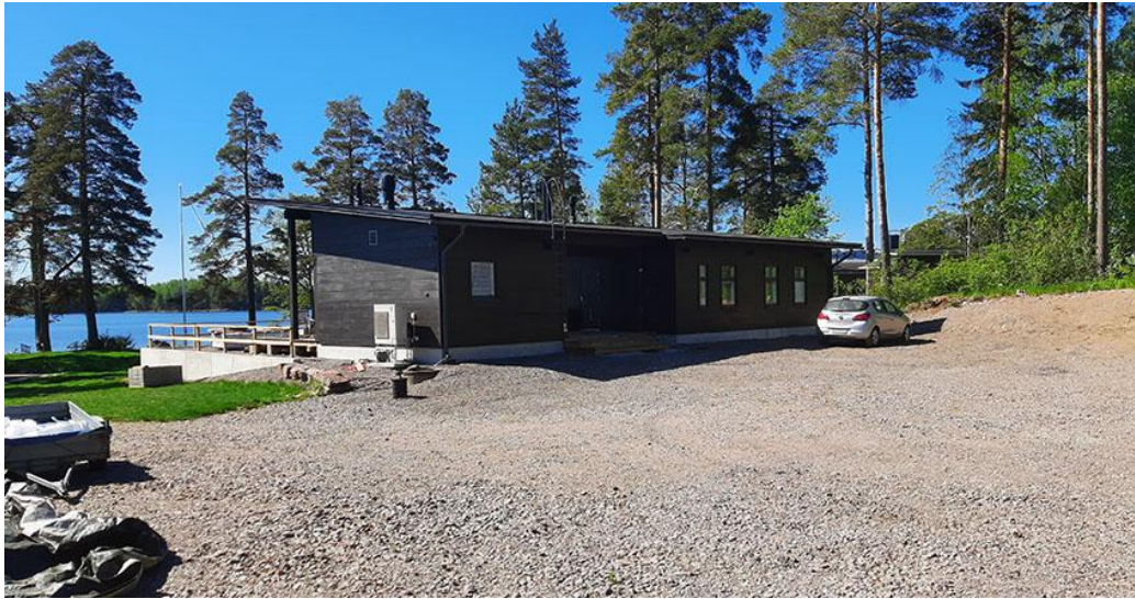
Kuva 5. Juuri valmistunut loma-asunto.
